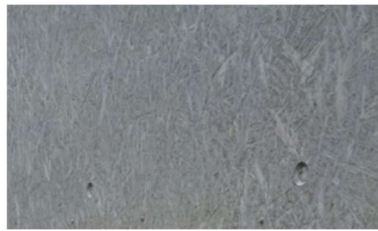
OSB-Sichtbeton Oberfläche
